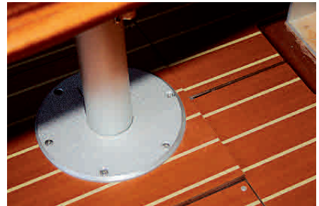
Wackelig: Der Salontisch ist auf dem Bodenbrett nur unzureichend befestigt
